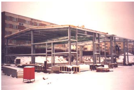
Baubeginn der Fahrzeughalle
