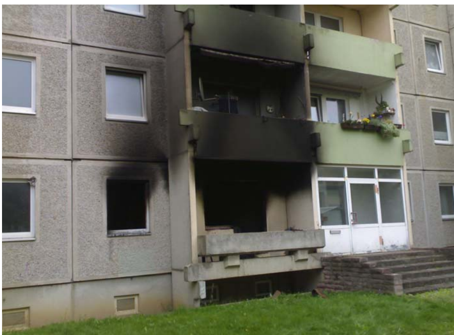
Wohnungsbrand Hochhaus Ziolkowskistr. am 11.09.2010
